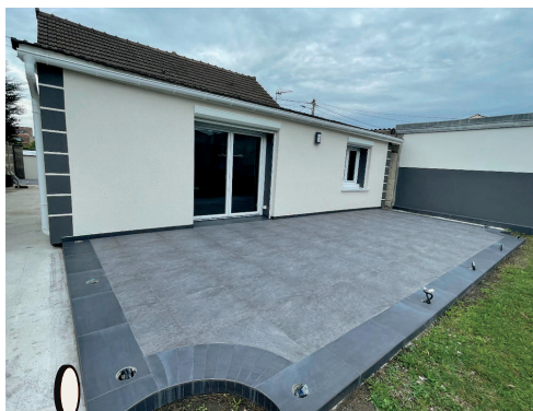
Isolation jusqu'au sol avec une plinthe carrelage
